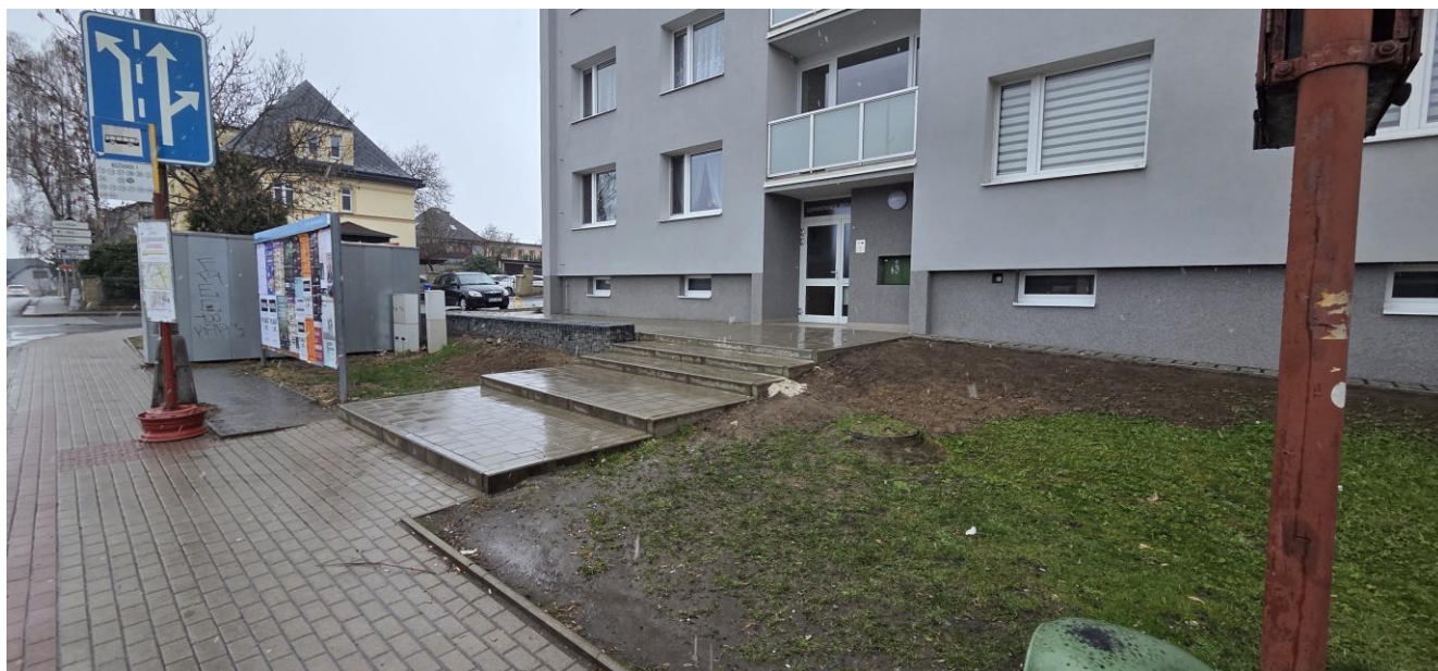
Obr. 3 – Přístup do objektu z čela
