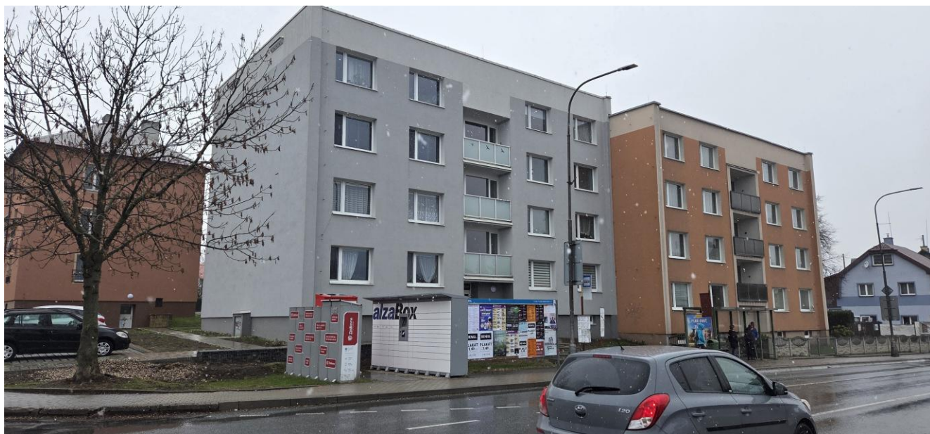
Obr. 1 – Nárožní pohled na objekt s severovýchodním průčelím a jihovýchodním štítem
