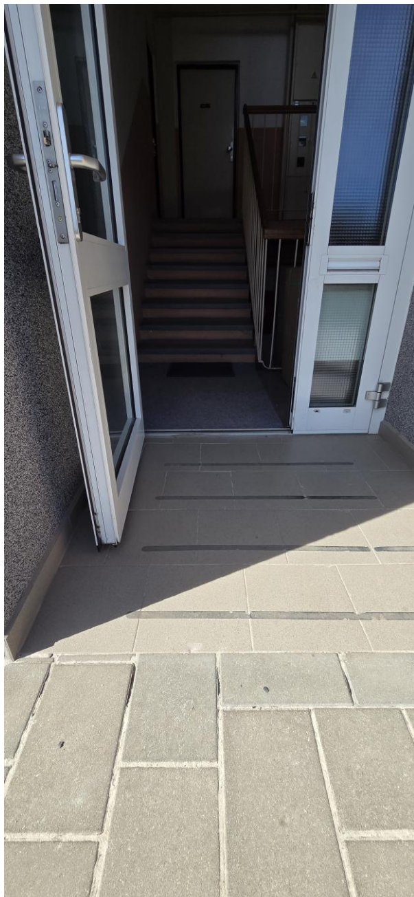
Obr. 5 – Detail vstupu do objektu na mezipodestu mezi 1. PP a 1. NP
