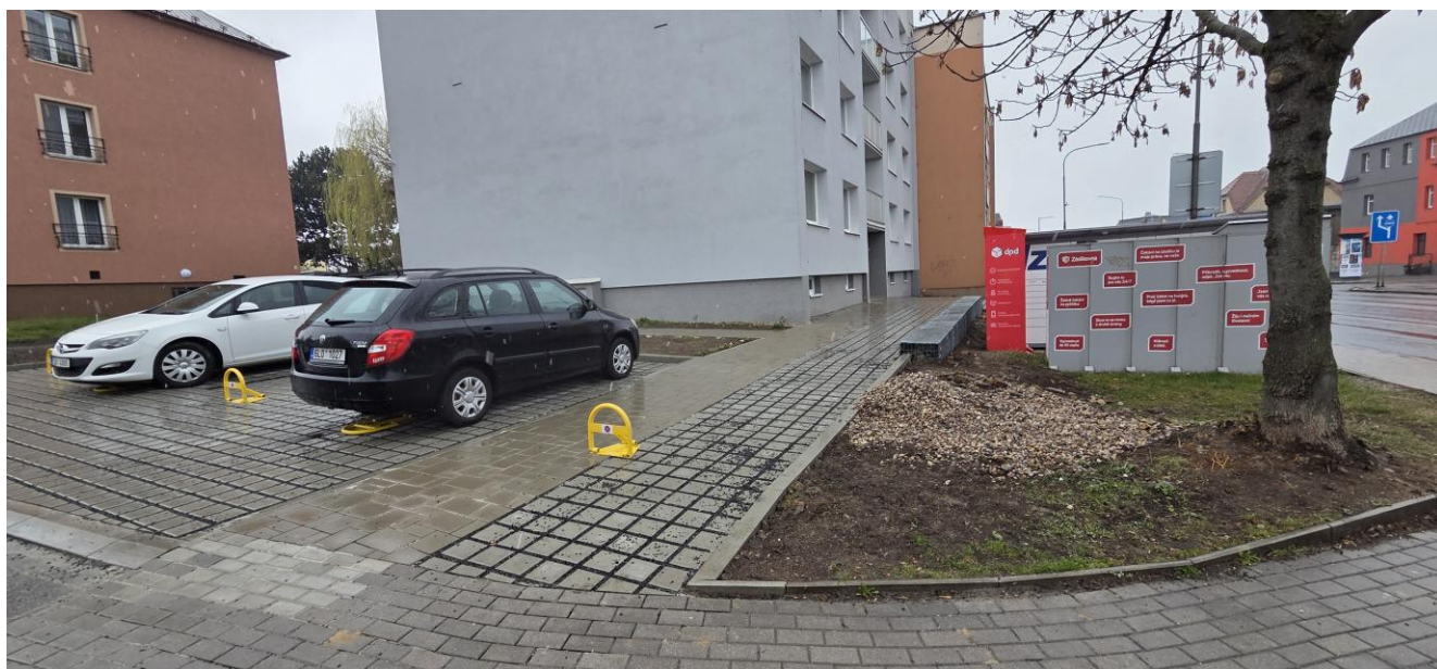
Obr. 4 – Pohled na bezbariérový přístup do objektu z boční strany
